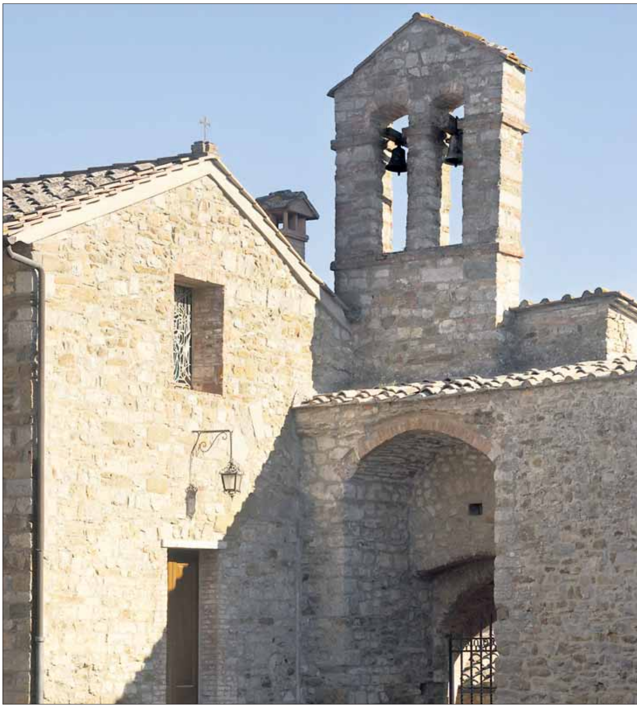
Die Architekten standen vor der Herausforderung, das mittelalterliche Dorf zu erhalten und damit der spirituellen Atmosphäre des ehemaligen Klosters Rechnung zu tragen. Fotos: Richard Bryant/arcaid.co.uk
